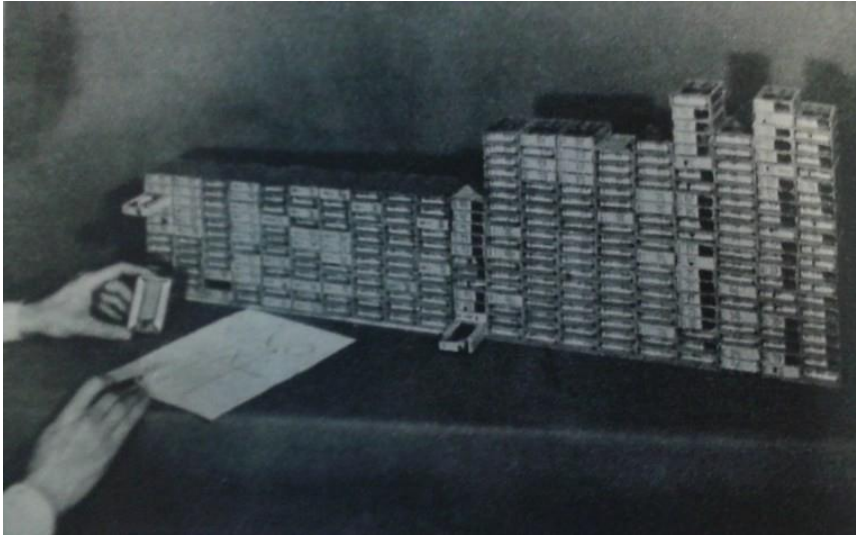
Abbildung 2: Donald Michies Maschine zum Erlernen des Spiels Tic Tac Toe [4]
