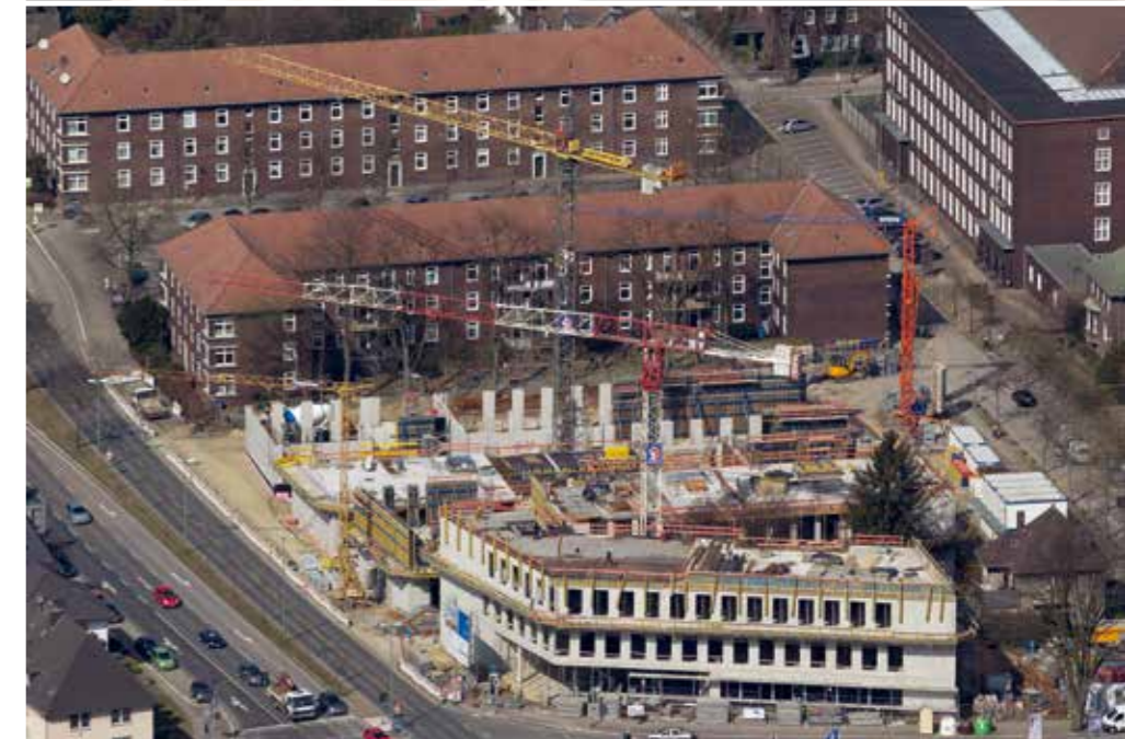
Oben / unten: Baustelle Bottrop im Mai 2013.
