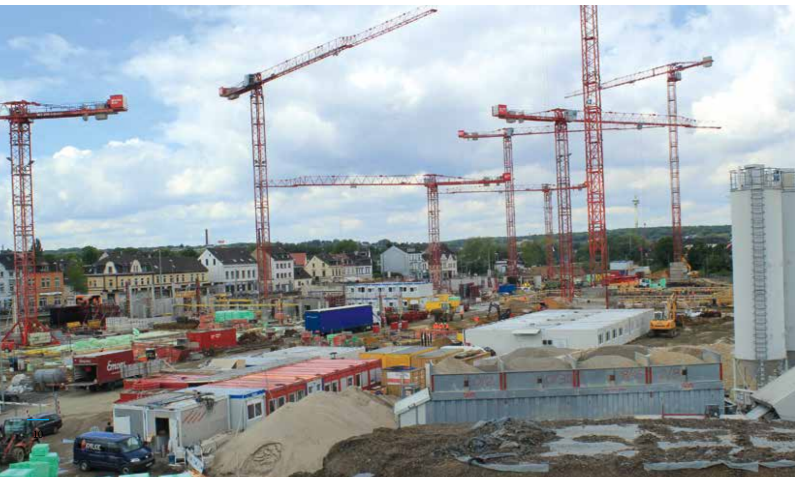
Baustelle Mülheim an der Ruhr im Mai 2013.
