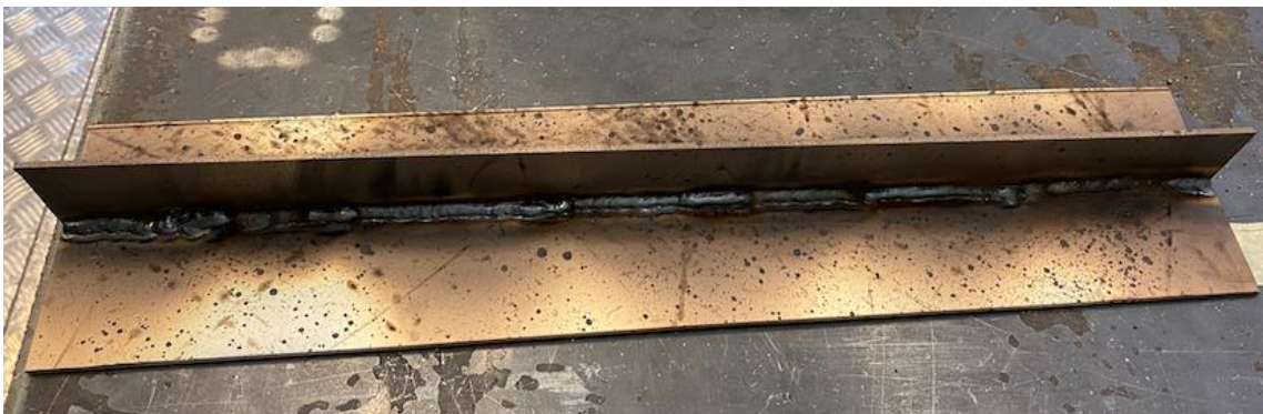
Abbildung C 5: Herstellung einer Flachlängssteife mit der Schweißfolge aus C1
